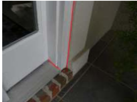
E. Door perimeter sealant
